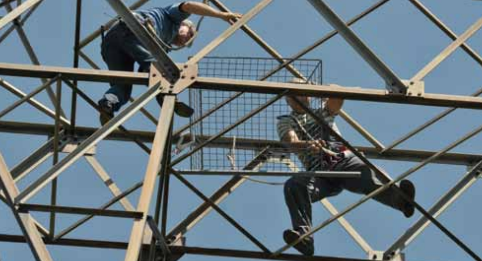
Поставување платформи за гнездење на царски орли на високонапонски далеководи Construction of nesting platforms for Imperial Eagle on high-voltage pylons
